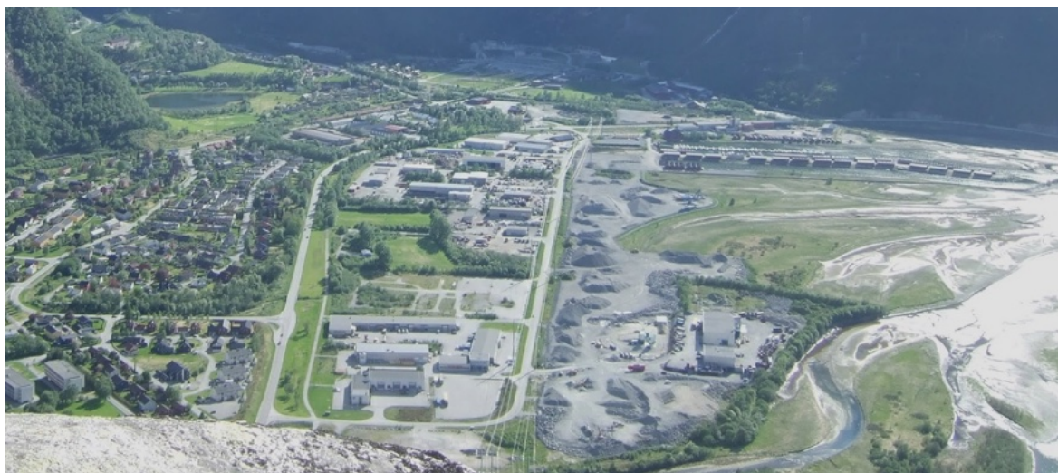
Figur 20. Deler av Håsørene og Sunndalsøra sett fra Flaggnuten i mai 2013. Massene fra Oppdølstrandtunnelen er stort sett kommet på plass. Foto: JBJ.
